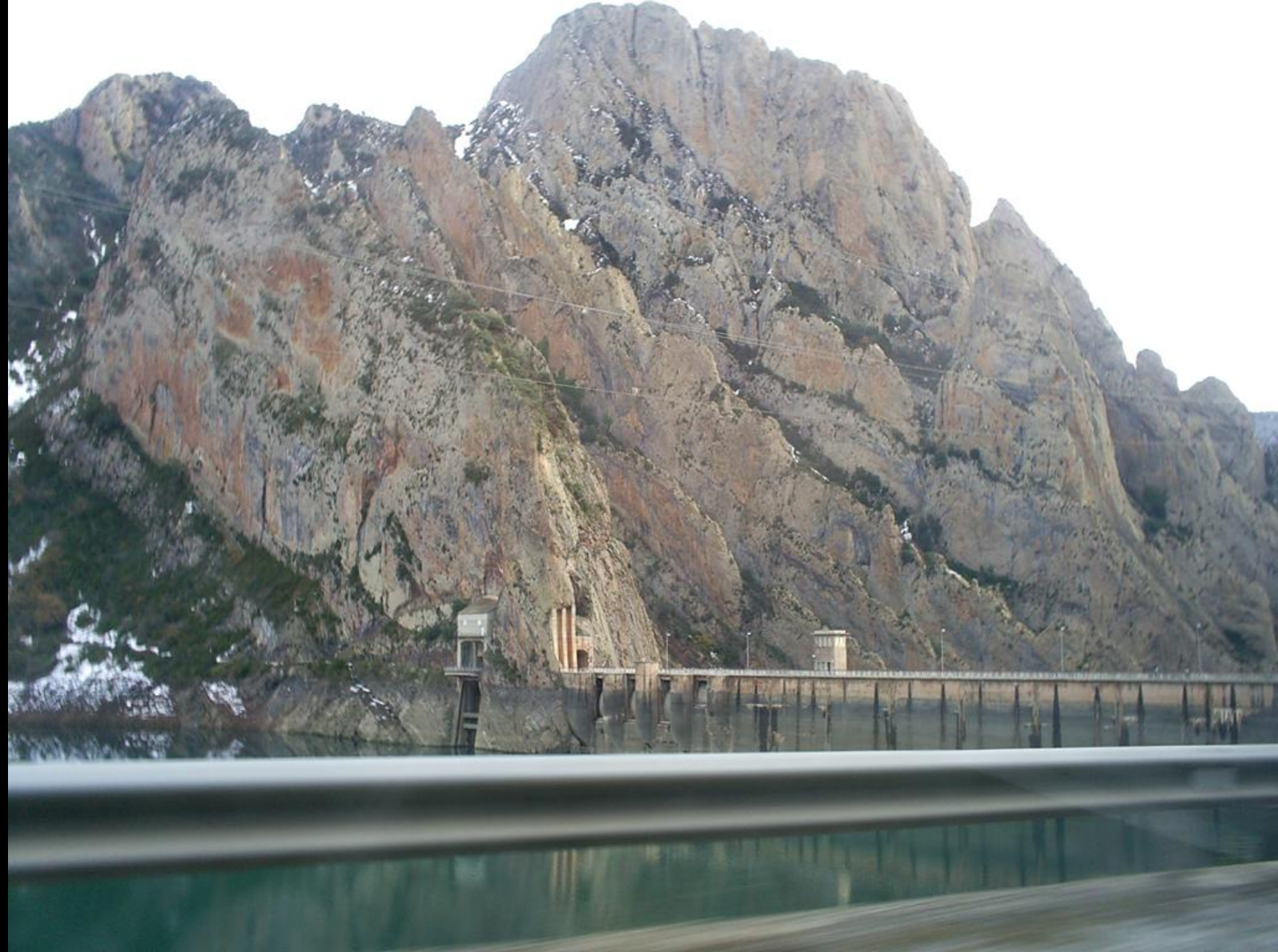
Embalse de Senet, en el Noguera Ribagorzana, entre Huesca y Lérida. Planta y cerrada en calizas 'Dalle' del Devónico Inf. Centro E Hoja de Benasque. (por Rub851-Google)
